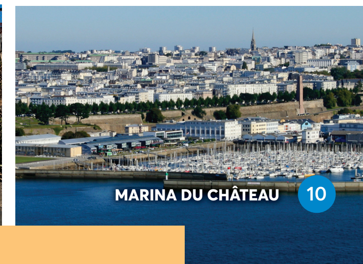
DIGUE LA PÉROUSE 11
