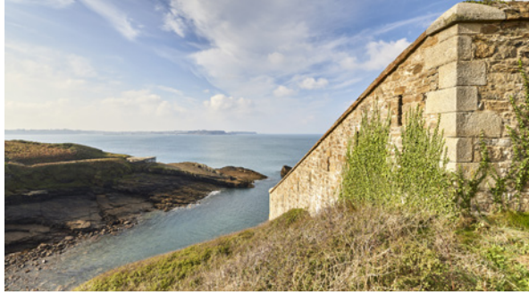
Fort de la Fraternité – Route des fortifications – Roscanvel
