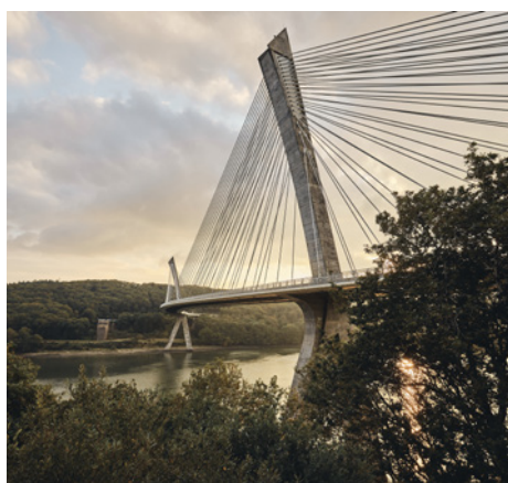
The Térénez bridge.
