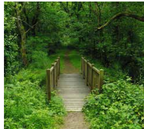
Passerelle Bois du Névet
